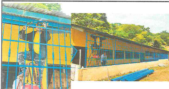
FOTO 1: INSTALACIÓN DE LA BARANDA DE METAL CON ANTULAR, HIERRO LISO Y PLANAS
