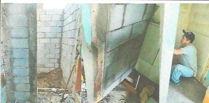
FOTO 5: REALIZARON EL LEVANTAMIENTO DE PAREDES DE BLOCK EN LOS SERVICIOS SANITARIOS
