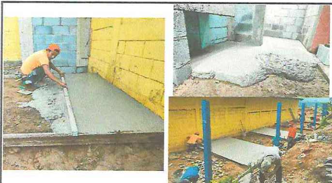
FOTO 3: SE CONTINUÓ CON LA PREPARACIÓN DEL TERRENO Y LA FUNDICIÓN DEL PISO DE CONCRETO
