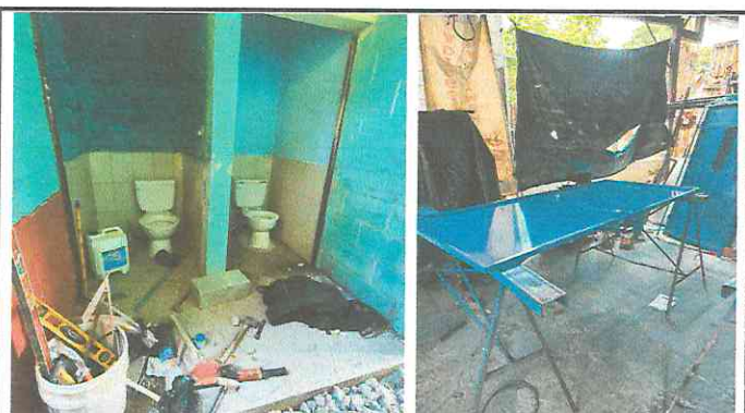
FOTO 4: DESMONTAJE DE PUERTAS DE BAÑOS Y DE LAS AULAS PARA SER REPARADAS Y PROCEDER A LA REINSTALACIÓN. MAS LA ELABORACIÓN E INSTALACIÓN DE DOS PUERTAS DE BAÑOS.
